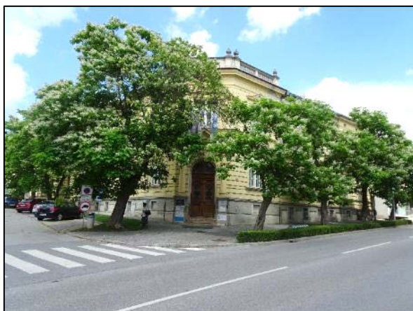
JZ pogled na stavbo s ceste.
